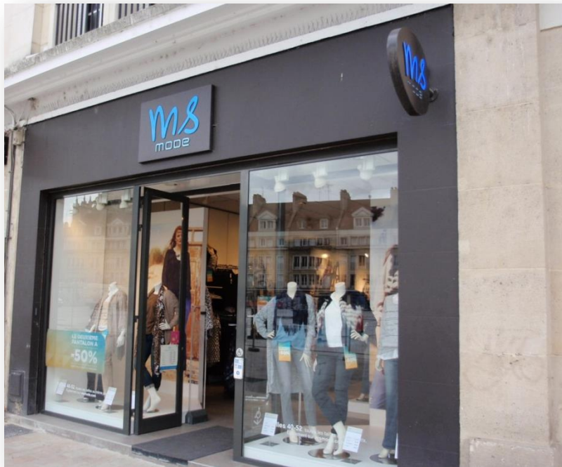
Enseignes à plat et perpendiculaire au mur support
